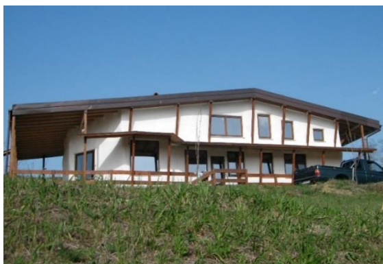
Casă din baloți de paie, Șendriceni, Botoșani, suprafața: 140 \text{ m}^2
