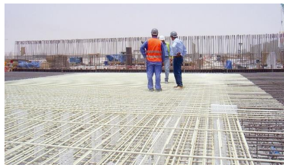
Figura 3.69 Armarea planșelor cu bare din CPAFS
