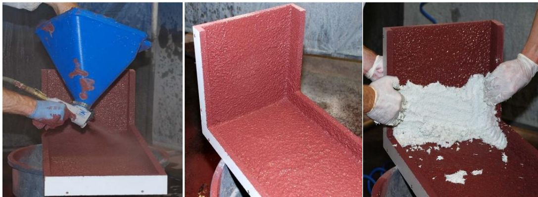
Fig. 2.3 Realizarea betonului armat cu fibre de sticlă prin procedeul mixt.
